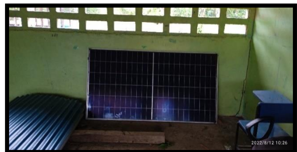
Paneles Solares desmontados C.E. Calante.
