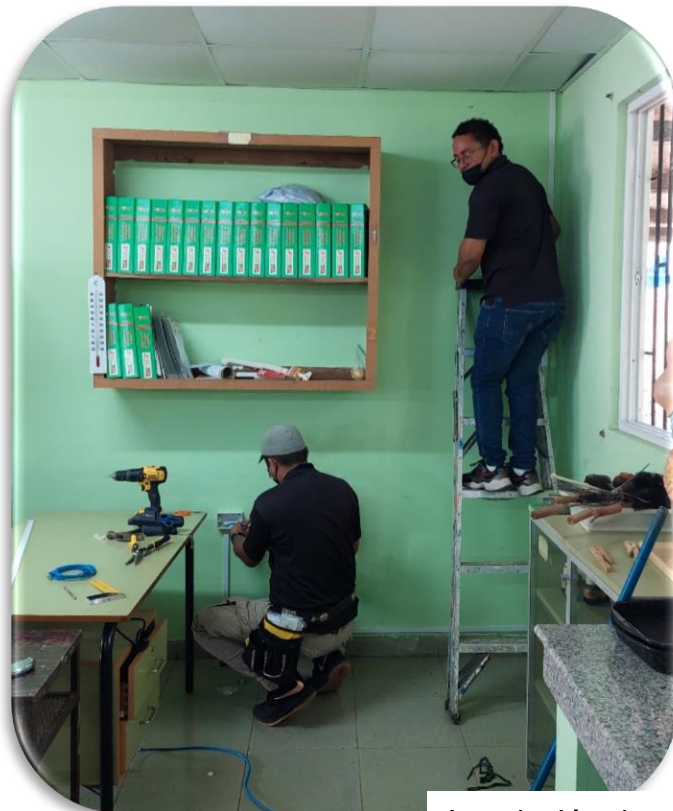
Instalación de punto de red en laboratorio de Ciencias
